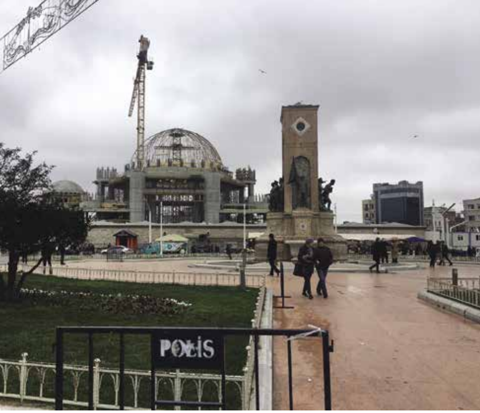
Taksim Camisi inşaatı (Fotoğraf: Korhan Gümüş).
