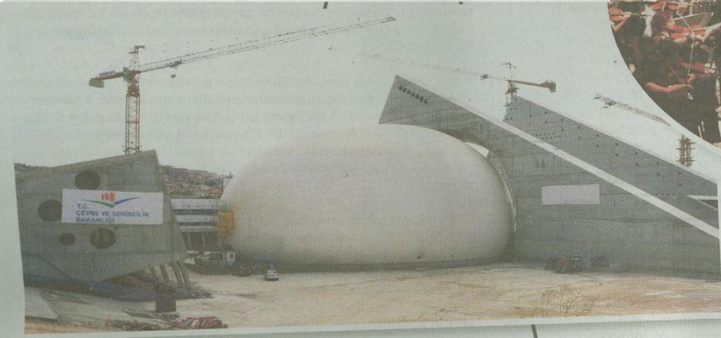
Yapımı devam eden yeni CSO binası...
